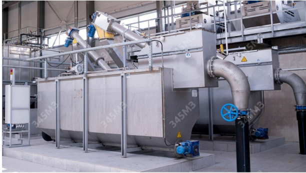
Рис. 1. Комбинированная установка механической очистки решетка-песколовка
