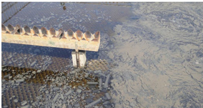
Рис. 2. Скопление грязи на верхней части модулей
